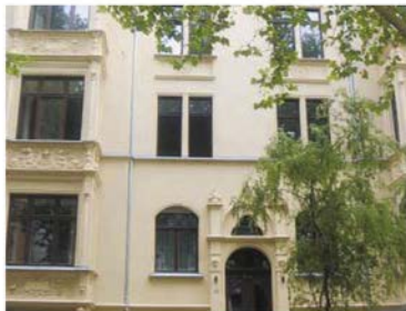
Objekt 1 – Phoenix in der Schiersteiner Straße.
